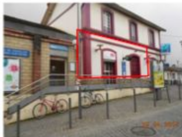
Vue du BIR depuis l'extérieur de la gare
